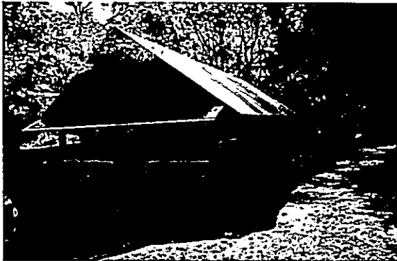
Figura 028. Resultado del trabajo hecho en la habilitación del dormitorio. En los muros se usó piedra unida con mezcla hecha a base de cal y para el techo lamina de zinc
