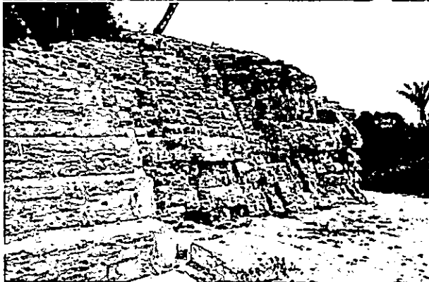
Edificio B-24, fachada norte. Resultado de los trabajos de estabilización de sillares.
