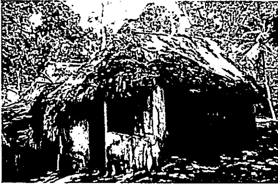
Figura 027. Estado en de la infraestructura antes de iniciar con el proceso de remozamiento. el resto del campamento se encuentra en condiciones similares
